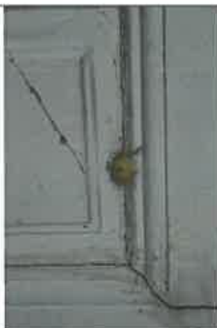
Ușă de intrare interior - starea generală de conservare este una precară- imagine de detaliu - prezintă urme avansate de uzură funcțională
