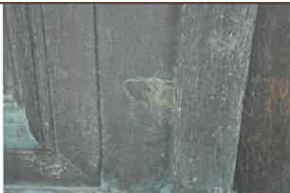
Detaliu de uzură funcțională - stratul protector este îmbătrânit și acoperit de murdărie aderentă
