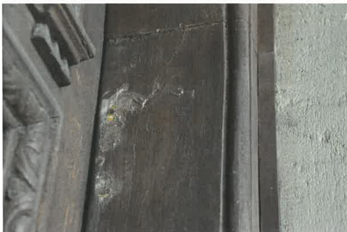
Degradare biologică - mucegaiuri și fungi.
