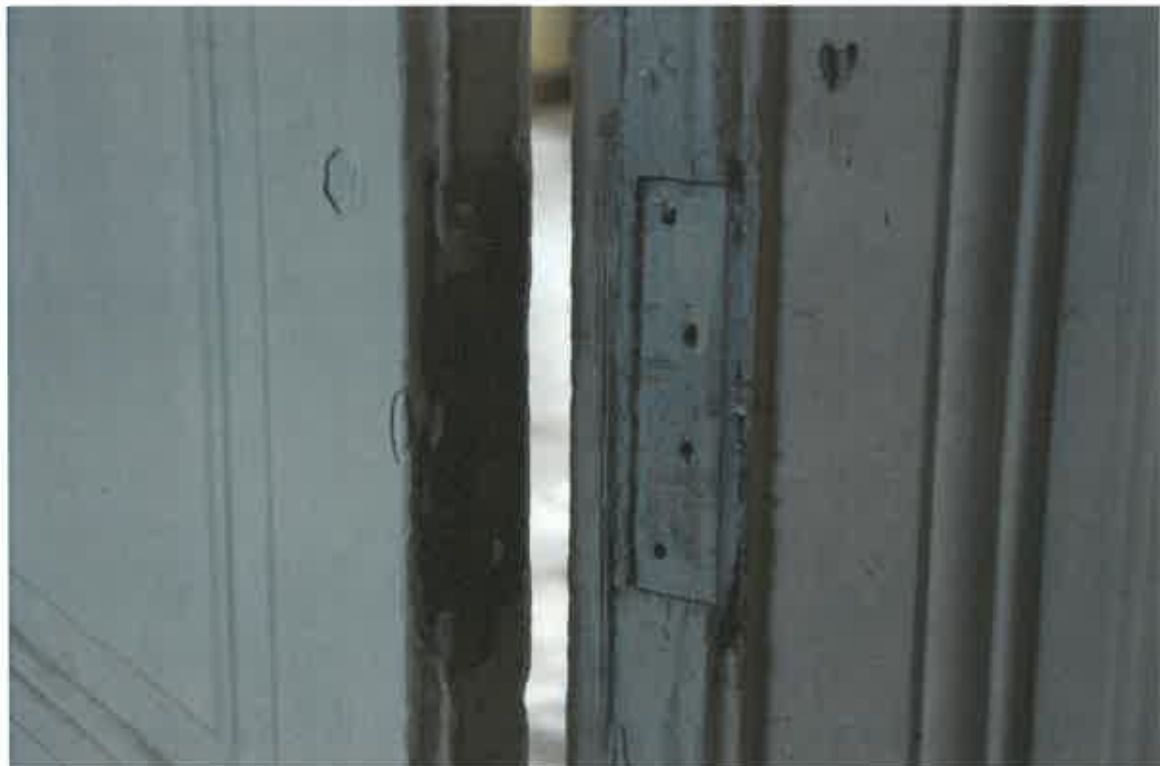
Anularea și îndepărtarea balamalelor originale de la mijlocul tuturor foilor de ușă.
