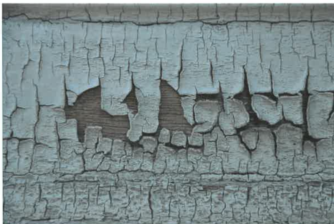
Degradarea straturilor de vopsea aplicate în epoci diferite, fibră lemnoasă uscată în exces expusă direct radiațiilor UV și cu o perioadă mare de timp (documentație fotografică realizată în luna august ac.)
