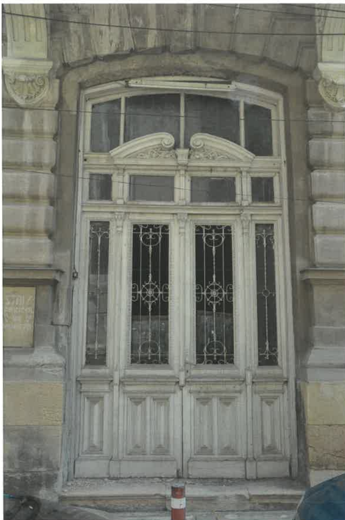
Fotografie ansamblu cu ușa de acces, fațada Nord-Vest. Infiltrații de ape pluviale provenite de la balconul etajului cu afectarea componentelor din lemn de la parter.
