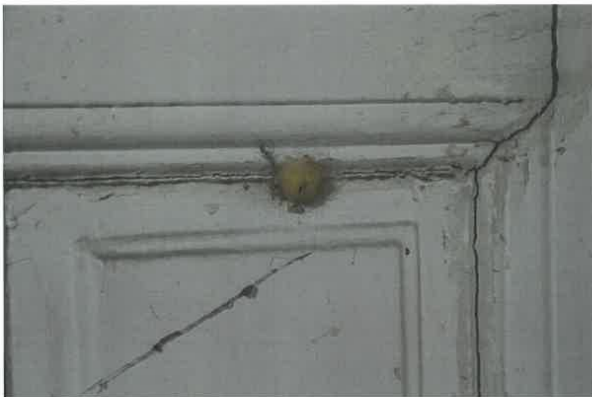
Depuneri de materii provenite de la insecte, desprinderi de asamblare căptușeli tocărie, chituiuri grosiere, lacune de vopsea.
