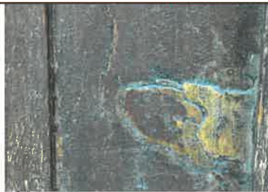
Detaliu de uzură funcțională - stratul protector este îmbătrânit și acoperit de murdărie aderentă
