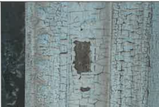
Locul de prelevare a probei nr. 2 - Latura de Vest, ușă intrare secundară - se remarcă dislocări, fisuri, desprinderi ale stratului protector și cu degradările specifice ale lemnului, detaliu
