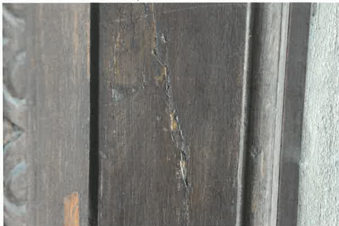
Reparații efectuate în timp, expulzate datorită contorsionării locale pe fibră a structurii lemnoase (ramificații de creștere, noduri).
