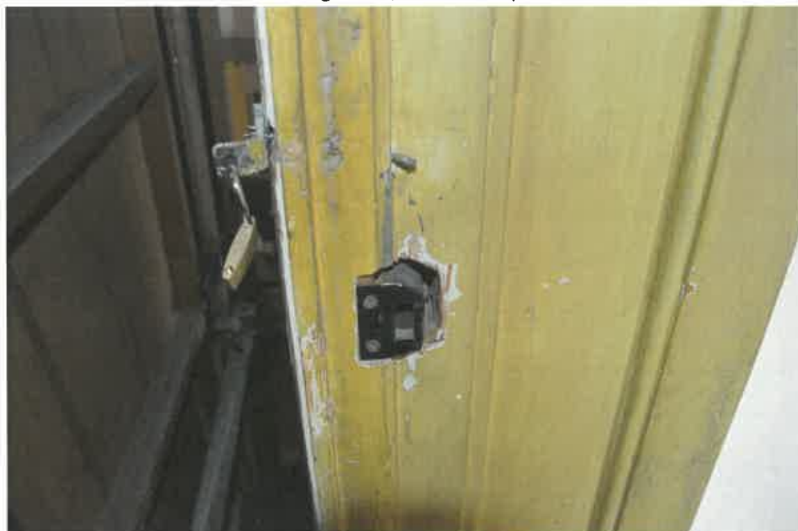
Modificări și debitări improprii, desprinderi de vopsea, uzuri graduale până la structura de lemn, vopsea înbrunată.
