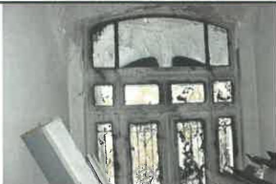
Locul de prelevare a probei nr. 3 - Ușa principală de acces - latura de Nord Est - imagine asupra stării generale de conservare din interior - se remarcă că aceasta prezintă numeroase degradări fizice și biologice
