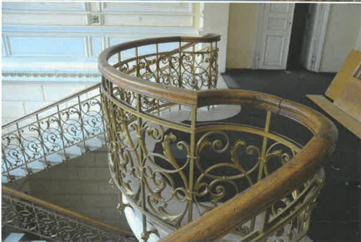
Acces dinspre foaier către etaj cu trepte din marmură, balustradă din fier forjat cu elemente decorative florale stilizate, mână curentă din lemn.
