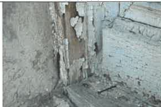
Locul de prelevare a probei nr. 1 - Latura de Est - ușă secundară de acces - imagine detaliată cu privire la starea de conservare a lemnului constituent - se remarcă zgârieturi, pierderi de material, uzură funcțională, zone expuse la umiditate și diferențe de temperatură
