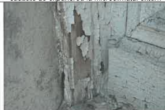
Locul de prelevare a probei nr. 2 - Latura de Vest - imagine detaliată asupra stării de conservare - se remarcă fisuri și desprinderi de material cauzate de expunerea la microclimatul extern
