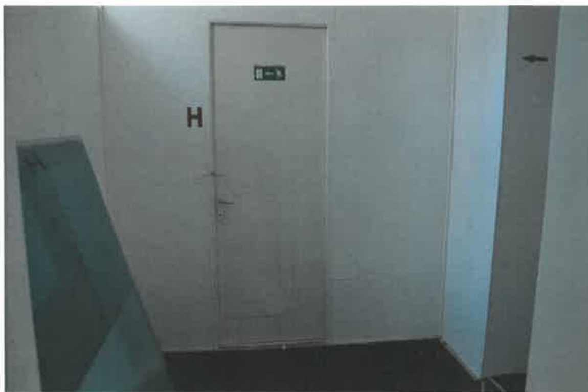
Adaptări de compartimentare cu adaosuri de pereți din rigips și uși noi din placaj.
