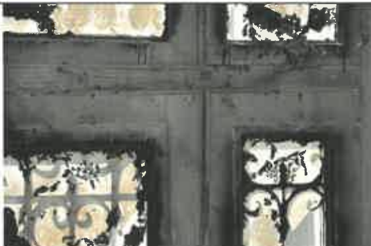
Locul de prelevare a probei nr. 3 - Ușa principală de acces - latura de Nord Est - imagine detaliată asupra stării de conservare din interior - se remarcă că aceasta prezintă numeroase degradări fizice și biologice
