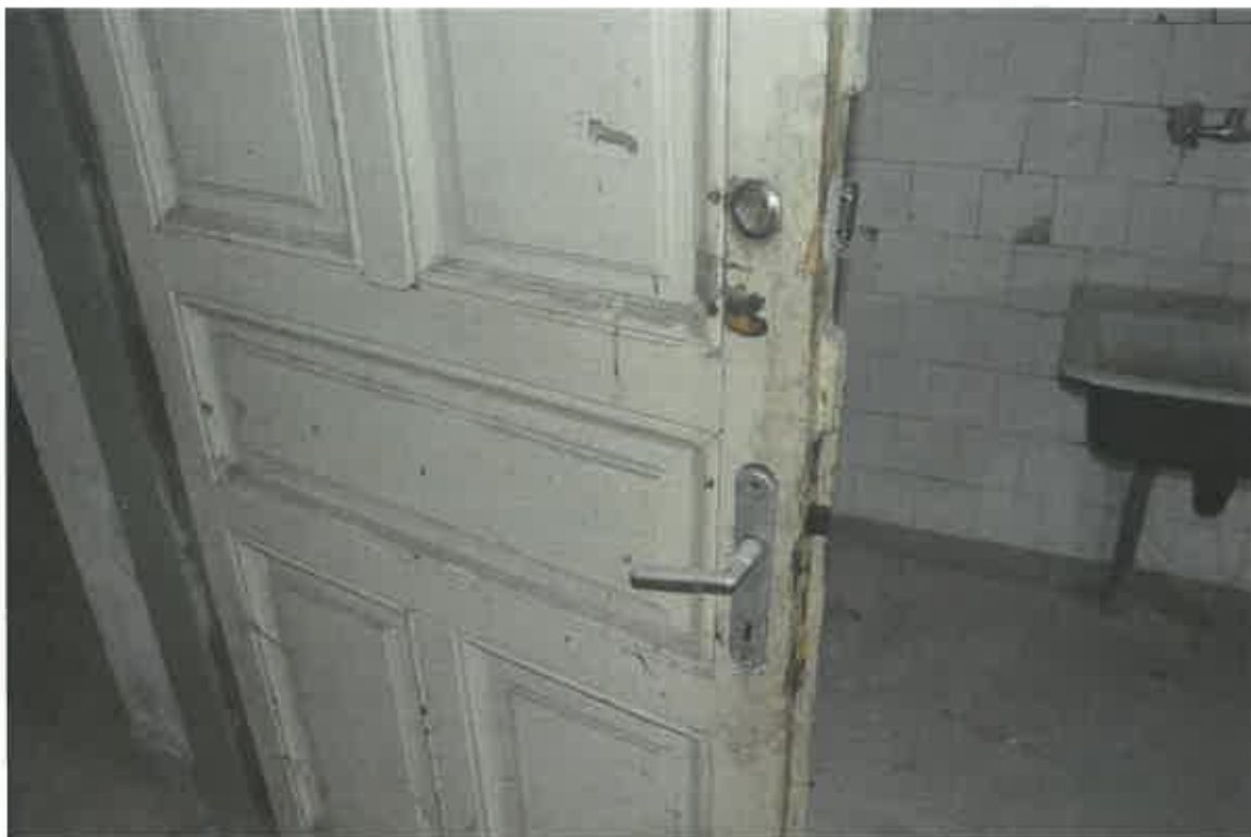
Uzuri de folosință, lovituri, zgrieturi, modificări, depuneri de murdărie, revopsiri.
