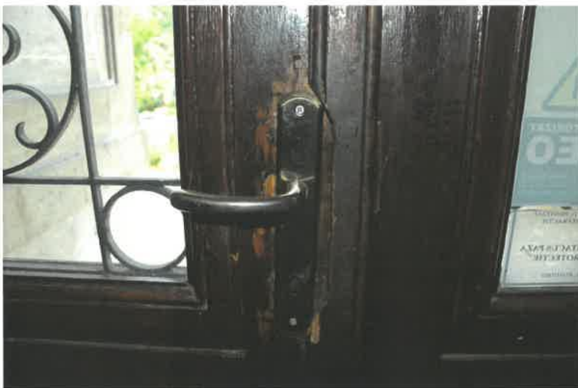
Modificări și adaptări pentru înlocuirea încuietorilor, uzuri, depuneri de murdărie ancrasată.
