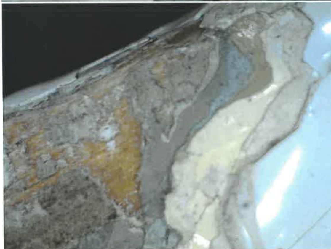
Desprinderi, clivaje între straturi cu strapări între suprapunerile de vopsea și grund ajungând până la nivelul fibrei de lemn.
