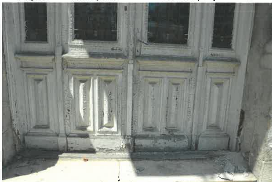
Evidențierea degradărilor de la ușa de pe fațada Nord-Est față de cea situată pe fațada Nord-Vest.
