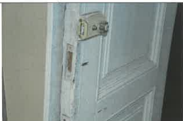
Ușă de intrare interior - starea generală de conservare este una precară - imagine de detaliu - a urme de uzură funcțională
