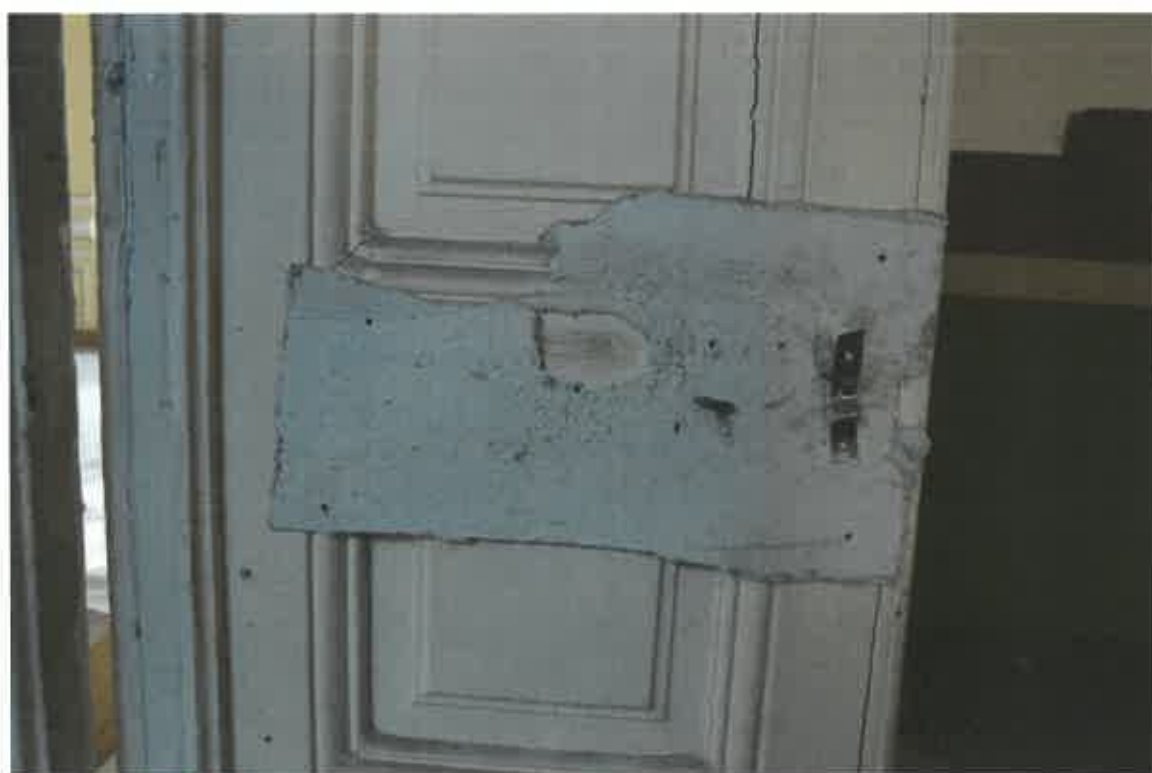
Degradări fizico-mecanice, improvizații improprii, fisuri în lungimea căptușelilor de pervaze.
