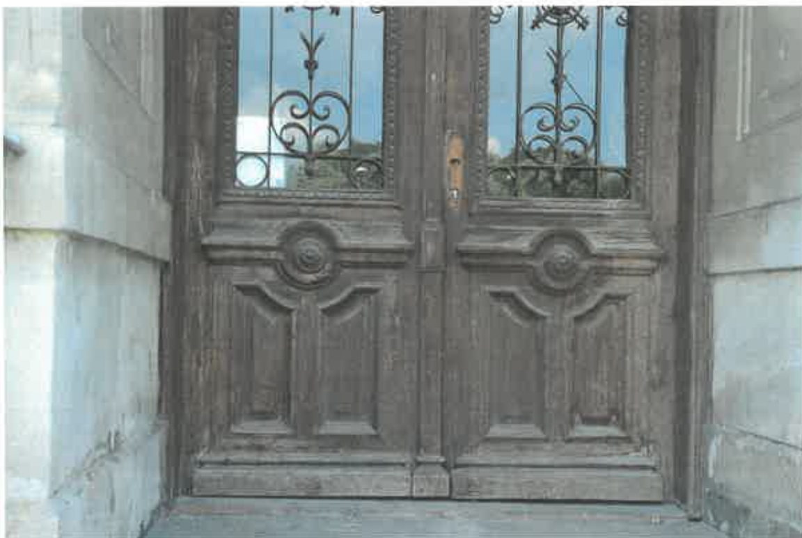
Degradare inegală a stratului de vopsea și a peliculei de protecție, eroziuni până la structura lemnoasă.
