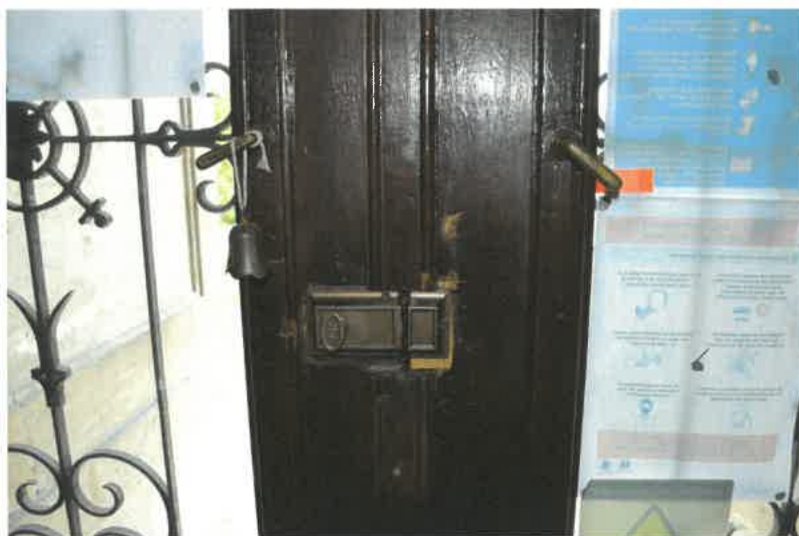
Modificări și adaptări pentru înlocuirea încuietorilor, exterior/interior.
