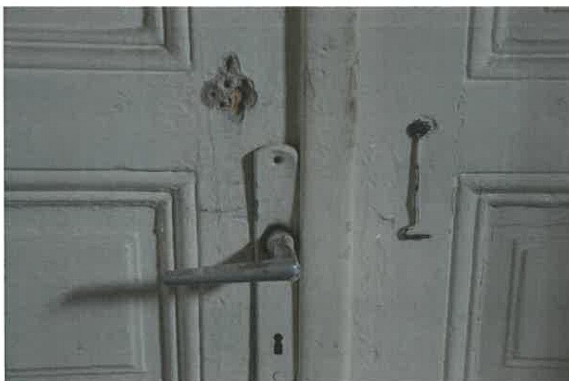
Adaosuri improprii, urme de degradări fizico-mecanice cu pierderi de structură de lemn, desprinderi de asamblare căptușeli tocărie, fisuri pe fibră, scursuri de vopsea.
