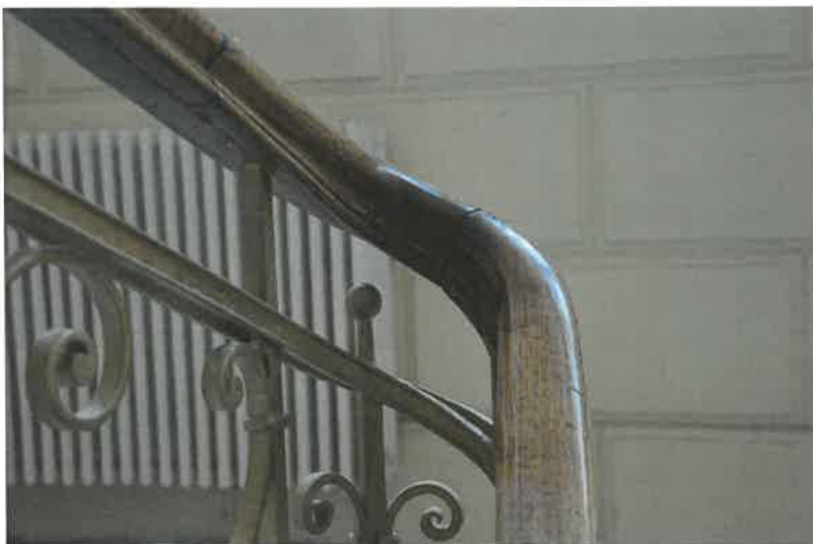
Suprafețe închise și deschise de fibră lemnoasă, mătuite și lucioase datorate curățărilor repetate cu soluții improprii.
