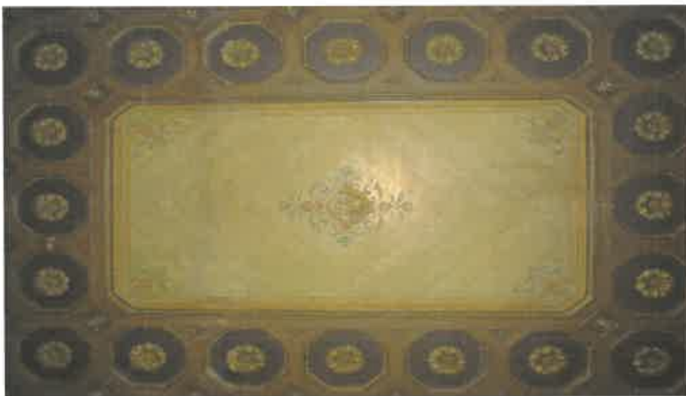
Decorațiuni murale în stuc, tavan casetat - imitație de lemn (fără ornamente pe pereții verticali).
