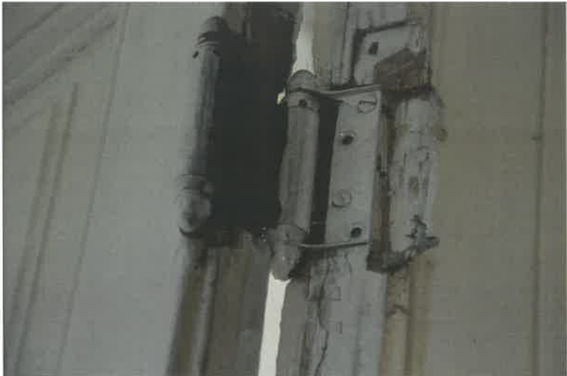
Înlocuirea balamalelor originale cu balamale de tip batant, cu prindere în zona superioară și inferioară a foilor de ușă.
