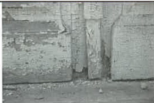
Locul de prelevare a probei nr. 1 - Latura de Est - ușa secundară de acces - imagine detaliată cu privire la starea de conservare a lemnului constituent - se remarcă zgârieturi, pierderi de material, uzură funcțională, zone expuse la umiditate și diferențe de temperatură
