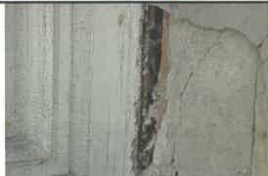
Locul de prelevare a probei nr. 1 - Latura de Est - ușa secundară de acces - imagine detaliată cu privire la starea de conservare a lemnului constituent - se remarcă un atac biologic de macromicete la contactul cu zidăria
