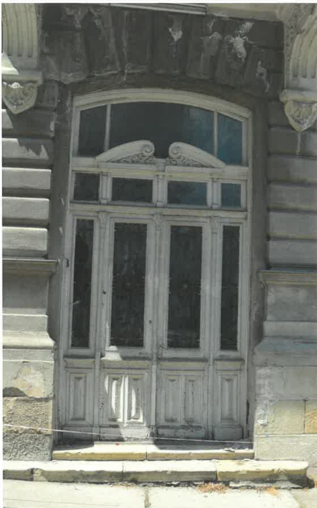
Fotografie ansamblu cu ușa de acces, fațada Nord-Est. Infiltrații de ape pluviale provenite de la balconul etajului cu afectarea componentelor din lemn de la parter.
